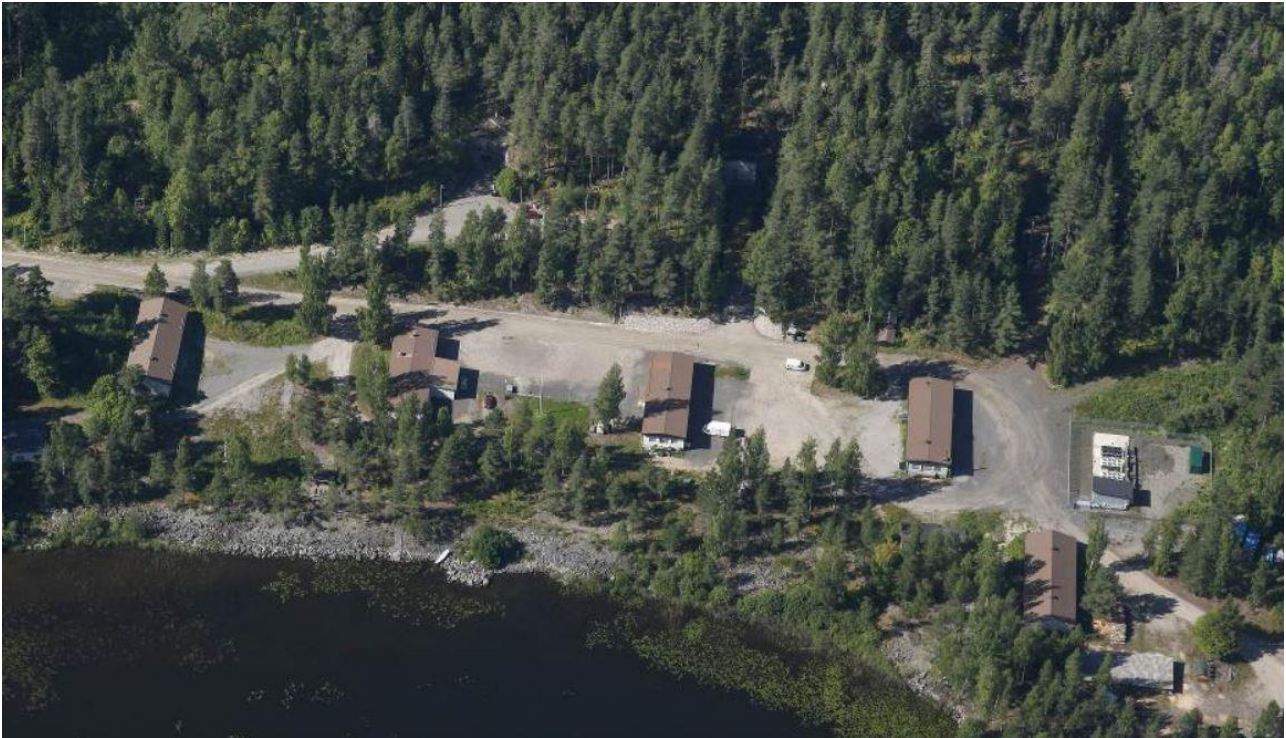
Kanavuoren kupeessa on puolustusvoimain entisiä varikkorakennuksia.
